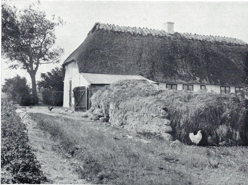
HJELMSBØVED. Ved øens nordre hus. Udhøene er bygget af sten og tang. (186)
