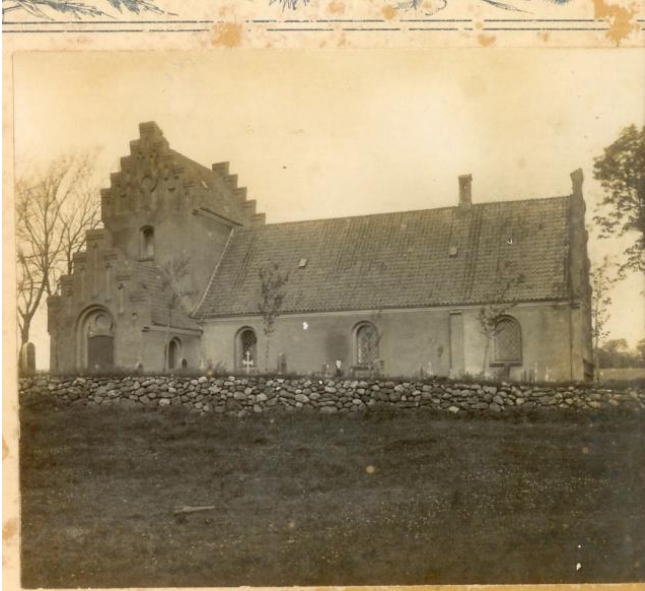
Drejø kirke med cement pudsning.
